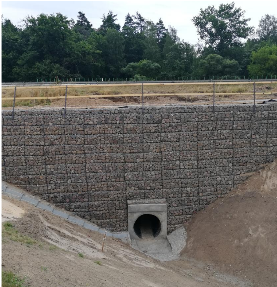
3 pav. Gabionų atraminės sienutės įrengimo pavyzdys (Lietuva)
