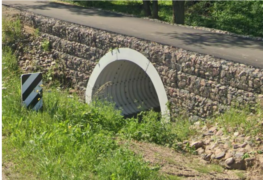
5 pav. Gabionų atraminės sienutės įrengimo pavyzdys (Lietuva)
