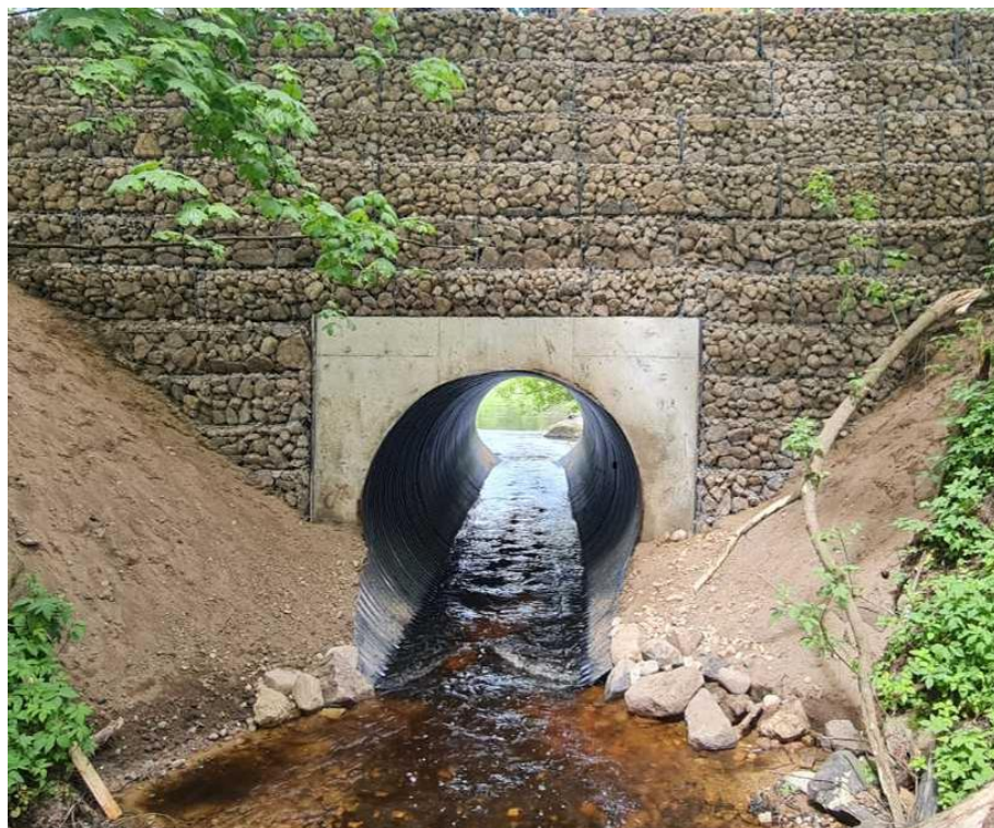
2 pav. Gabionų atraminės sienutės įrengimo pavyzdys (Lietuva)
