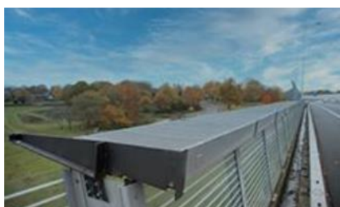
13 pav. Taikomos triukšmo užtvarų viršaus formos (Rekomendacijų 1 priedo 30 punktas)
