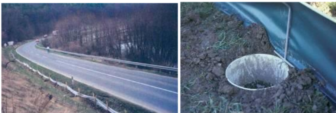
61 pav. Laikina tvora ir surinkimo spąstai varliagyviams (2 priedas [15])
