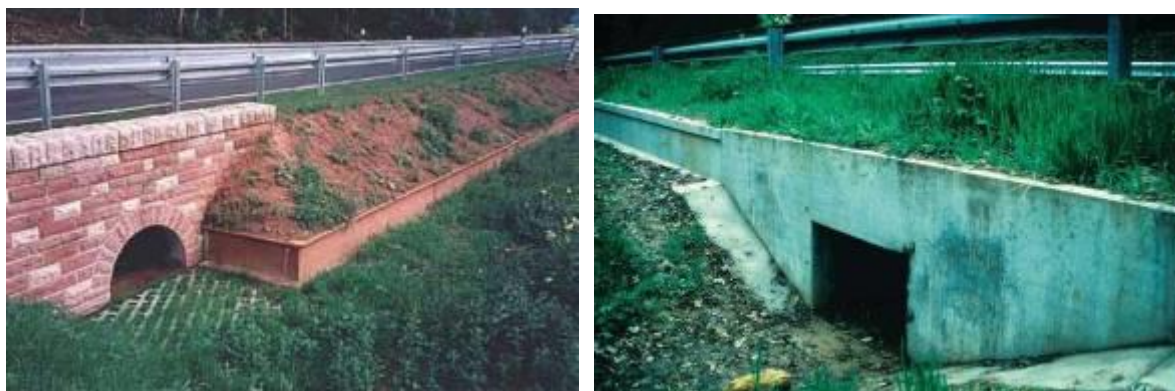
20 pav. Metaliniai (kairėje) ir betoniniai skydiniai atitvarai (atitveriamieji bordiūrai) (dešinėje) smulkiesiems gyvūnams. Kelio zonoje esantis smulkusis gyvūnas gali saugiai iš jos pasišalinti, o patekti ant kelio negali (2 priedas [15, 21])
