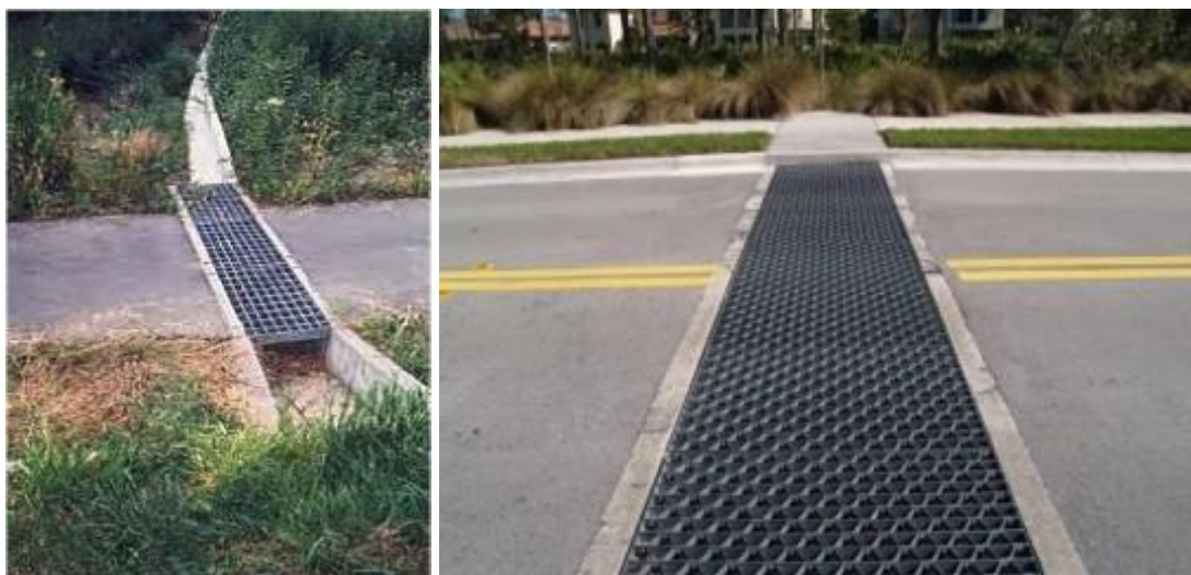
57 pav. Siaura perėja varliagyviams su šviesą praleidžiančia viršutine perėjos dalimi (2 priedas [21])
