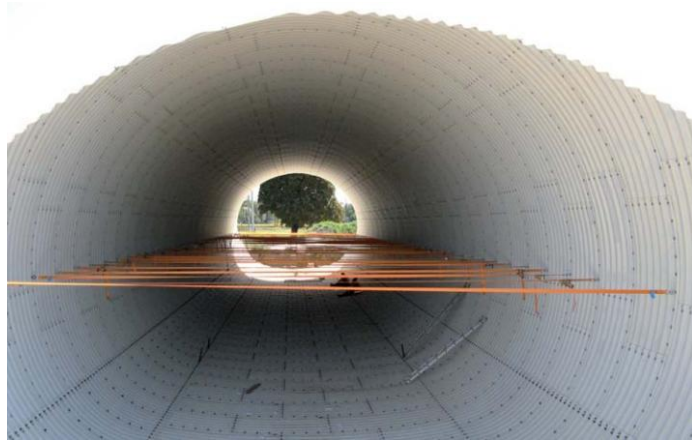
36 pav. Įtempimo diržai skerspjūvio formai išlaikyti
