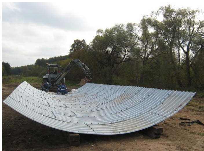
32 pav. Konstrukcijos surinkimas
